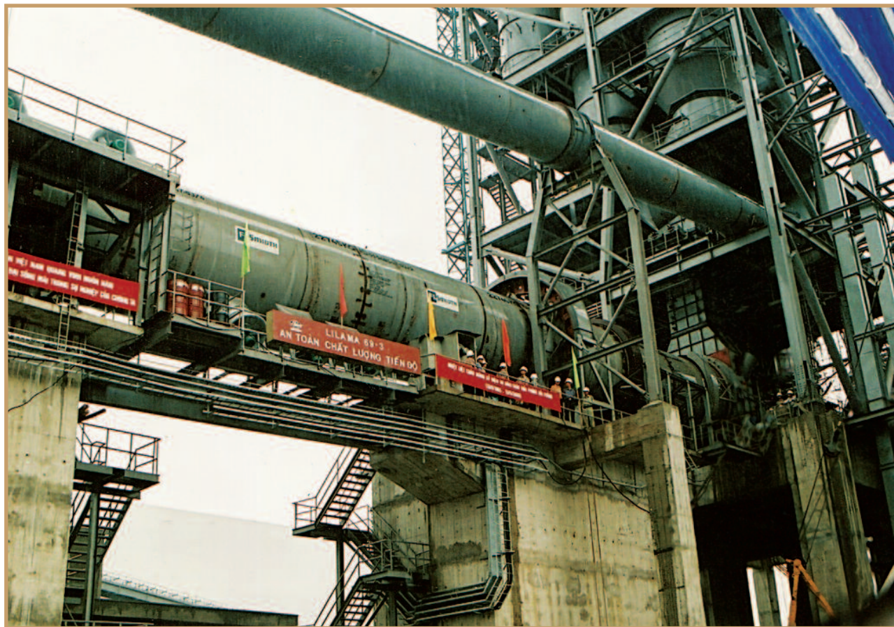
Hoàn thành lắp đặt hệ lò nung và nghiền liệu tháng 5/2005
