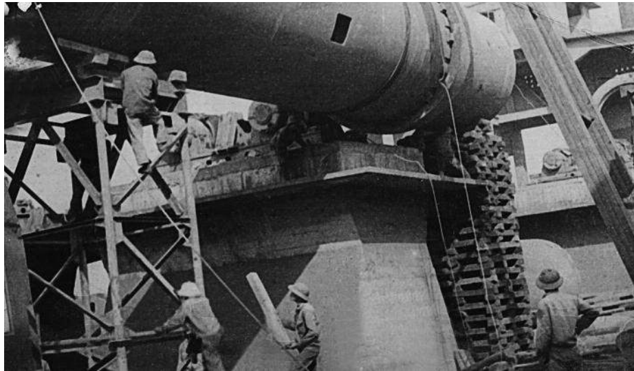
Lắp đặt Lò nung số 8 - Công trình mở rộng Nhà máy năm 1976
