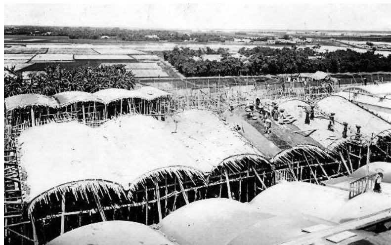
Đổ bê tông mái vòm Hangar (nhà kho) năm 1917 ▼
