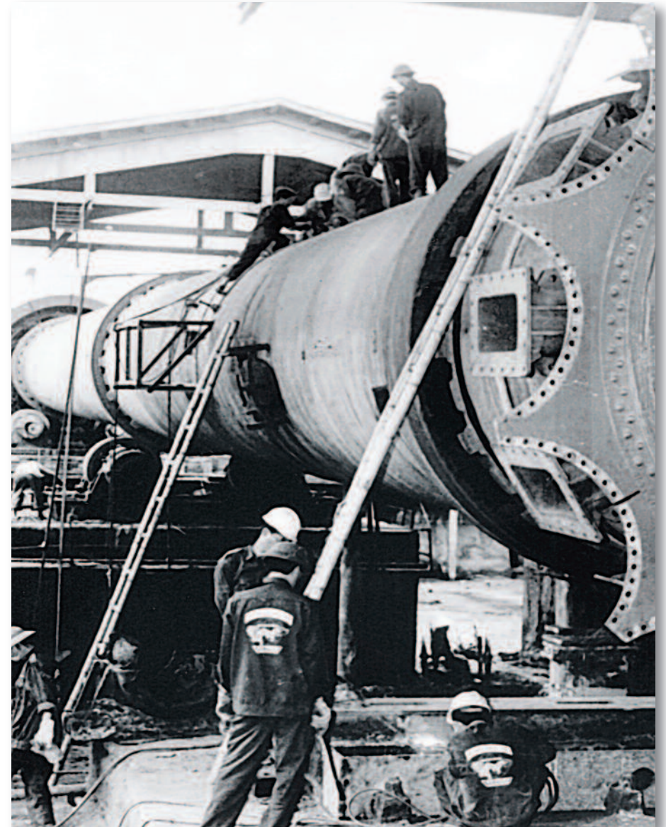
Công nhân Phân xưởng Lắp ráp sửa chữa bộ ga lê Lò 8
