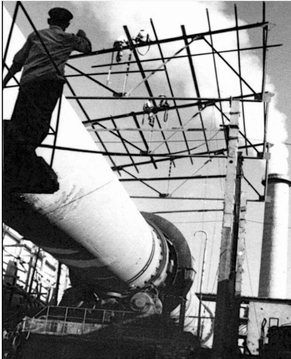
Công nhân Phân xưởng Mộc nề khẩn trương hoàn thành công trình mái che lò 7
