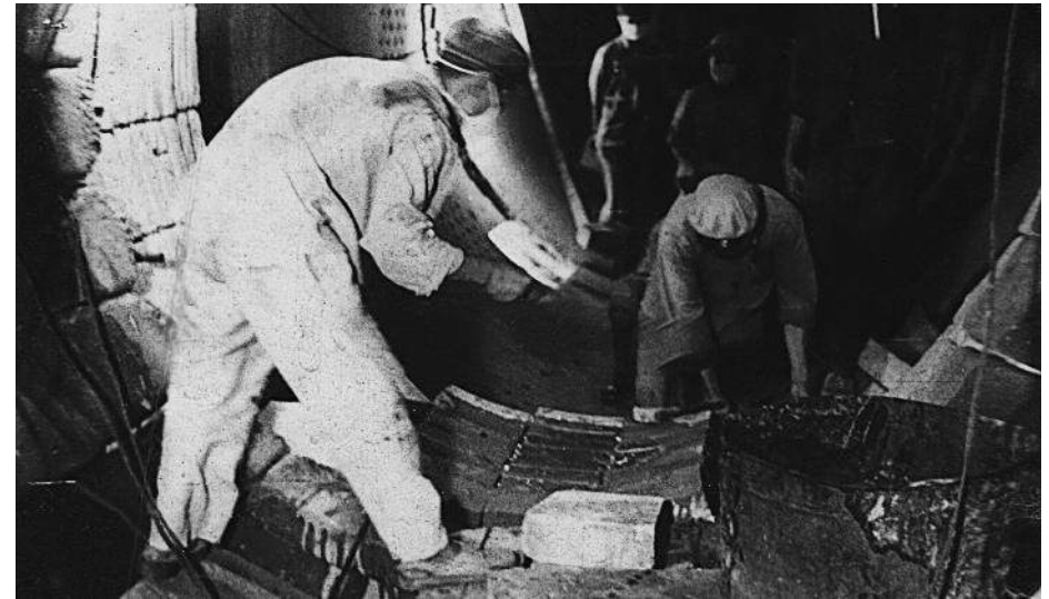
Tổ Nề 3, Phân xưởng sửa chữa công trình đang khẩn trương xây lại lò 4
