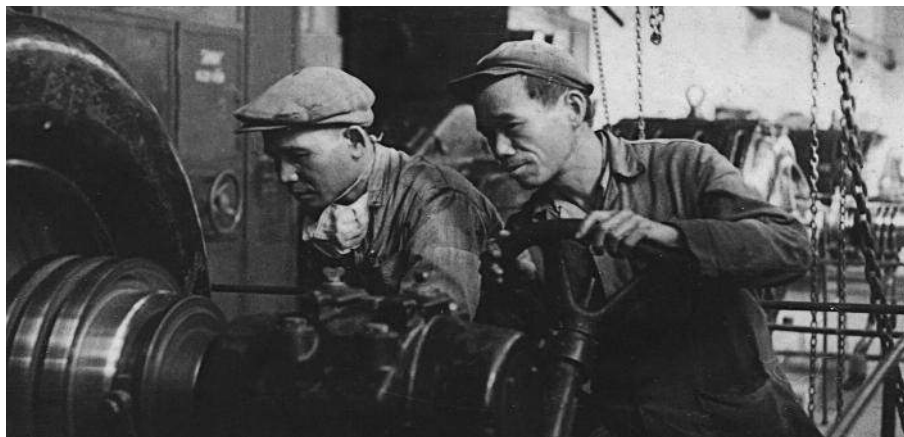
Công nhân Phân xưởng Động lực sửa chữa mô tơ máy nghiền bùn 5 (Phân xưởng Máy đá), tiết kiệm 330 công
