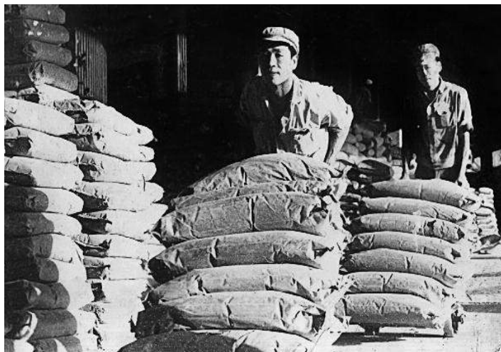
Công nhân Phân xưởng Nhà tháo vận chuyển xi măng vào kho
