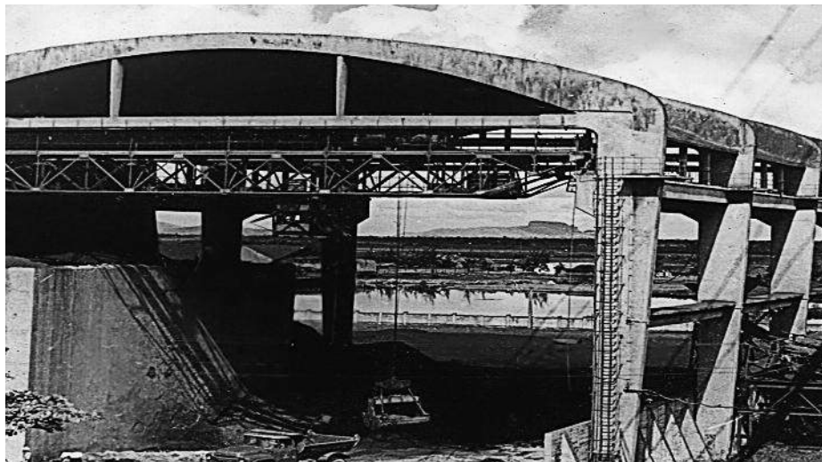
Hangar (kho) than – Phân xưởng than mịn
