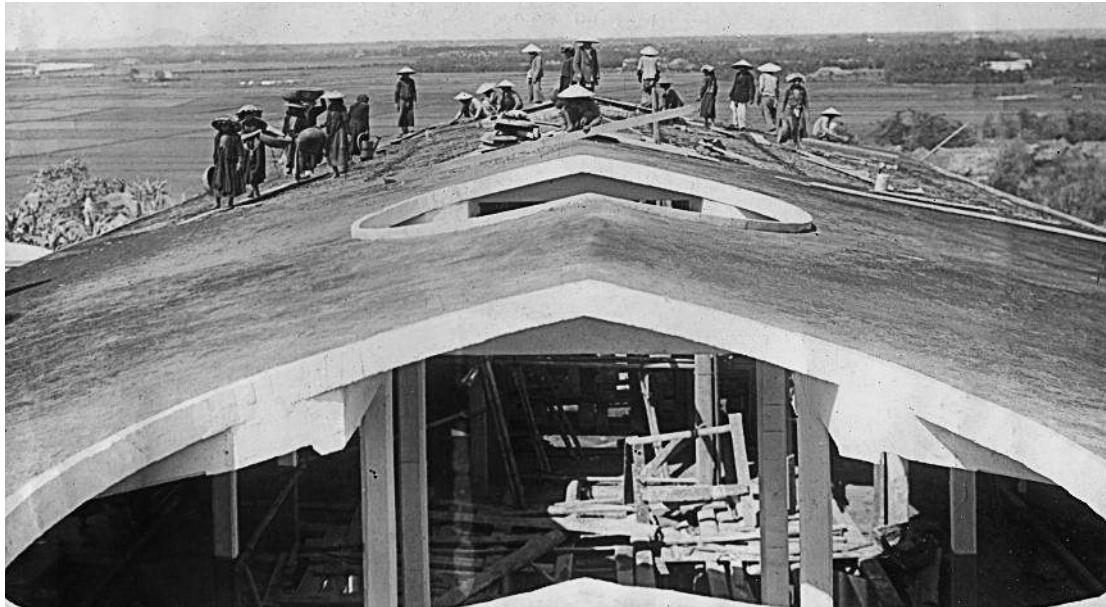
Lao động phụ nữ phải đội từng thúng vữa bê tông để đổ mái nhà kho
